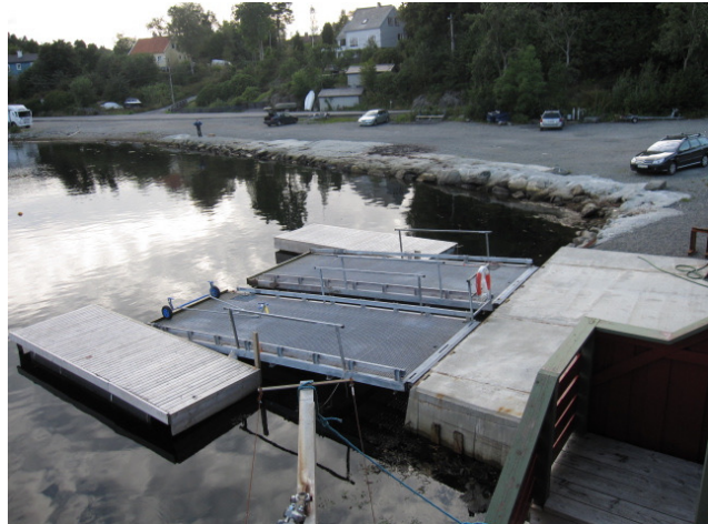
Dobbelslipp for utsett og opptak av sniper.
